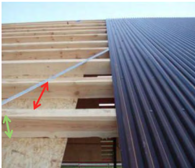
Figura 5. Struttura del doppio tetto
